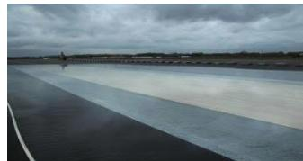
Das cds-Beschichtungssystem HB flex ist ein flexibilisiertes, pigmentiertes 2-Komponenten Reaktionsharz auf Epoxidharzbasis und findet Anwendung bei der Herstellung von glatten Beschichtungen auf Asphaltdeck- bzw. Asphalttragdeckschichten im Innen und Außenbereich.
