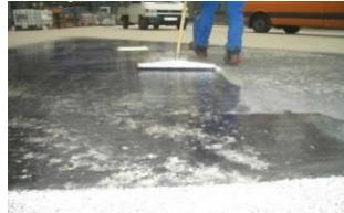
Das cds-Beschichtungssystem HB flex SF für Gussasphaltbeläge ist ein flexibilisiertes, pigmentiertes 2-Komponenten Reaktionsharz auf Epoxidharzbasis zum Beschichten von Gussasphalt im Innenbereich. Dabei können Beschichtungen mit glatter oder rutschfester Oberfläche gefertigt werden. Beschichtungsstärke ca. 2mm für mechanisch hoch beanspruchte Flächen.
