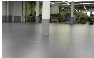
**cds-Versiegelung GBw** ist ein pigmentiertes, dampfdiffusionsfähiges, wasseremulgiertes 2-Komponenten-Epoxidharz-Konzentrat und wird im Innenbereich auf Böden aus Beton, Estrich, Anhydrit und Magnesit eingesetzt. Ungefüttert kann sie als Grundierung und Versiegelung verwendet werden. Gefüttert findet sie Anwendung als Kratzspachtelung und Industriebodenbeschichtung bei mittlerer mechanischer Belastung.
